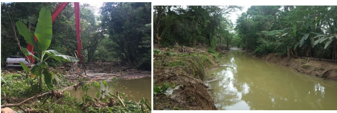
Figura 6: Limpieza canal Santa Rosa
