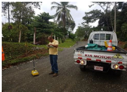
Figura 18: Proceso constructivo camino alternativo tránsito pesado puente Envaco
