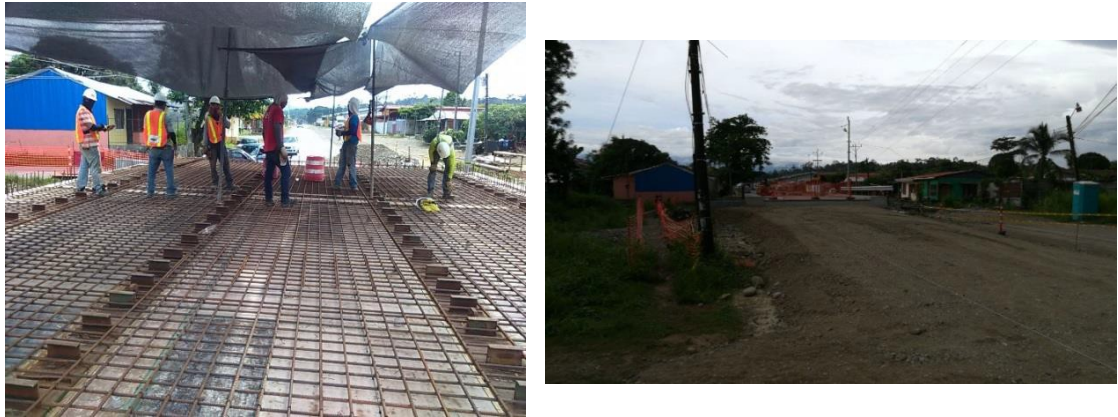
Figura 20: Proceso constructivo Puente Envaco
