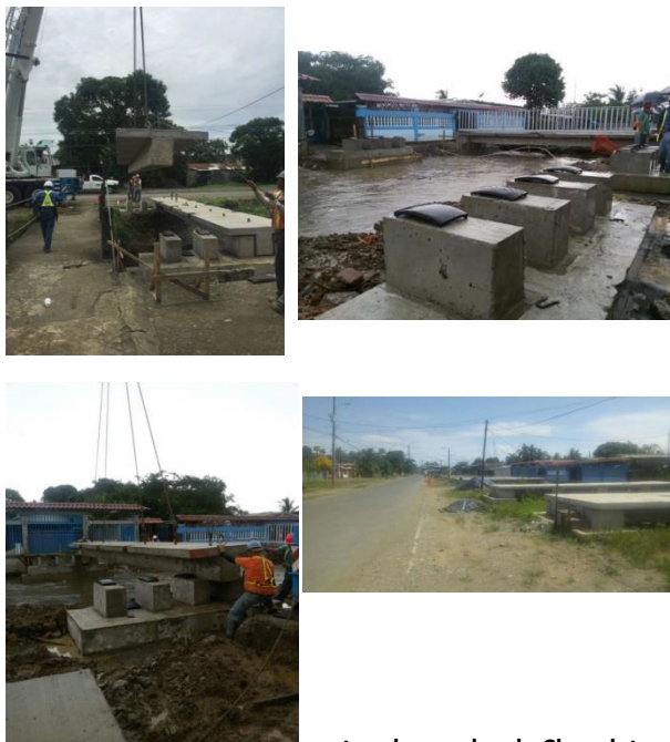
Figura 8: Proceso Constructivo Puentes peatonales quebrada Chocolate
