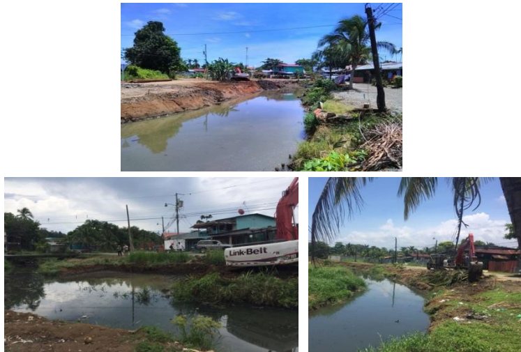
Figura 7: Proceso Constructivo río Limoncito
