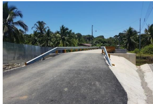
Figura 13: Puente Los Lirios
