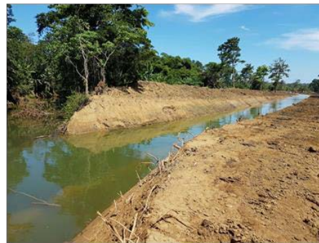
Figura 3: Proceso Constructivo Canal Traslase
