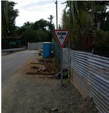
Figura 10: Señalización vertical Puente Recodo
