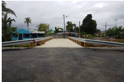
Figura 11: Proceso Constructivo Puentes Metálico
