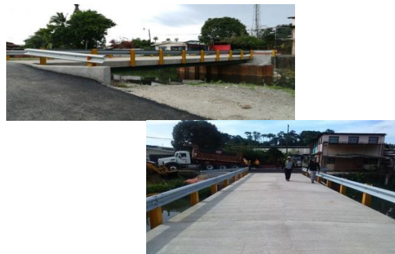
Figura 14: Proceso constructivo Puente Barrio Quinto
