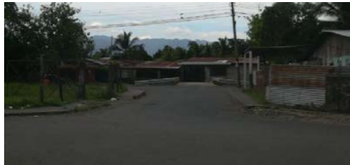
Figura 15: Proceso constructivo Puente Escuela
