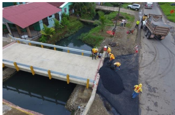
Figura 9: Puente quebrada Chocolate
