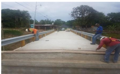
Figura 16: Proceso constructivo Puente Chocolate 2
