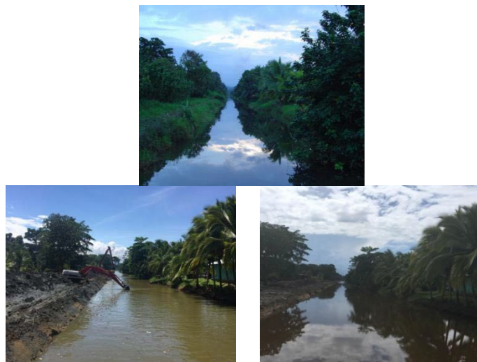
Figura 1: Proceso Constructivo Canal Japdeva
