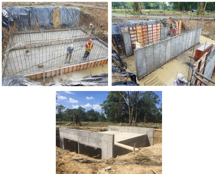
Figura 4: Proceso Constructivo Alcantarilla de cuadro Canal Traslase
