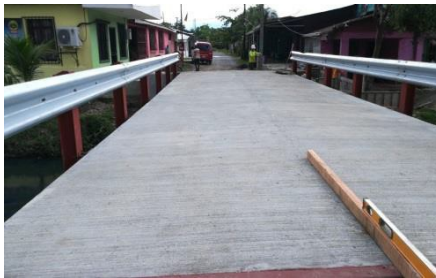
Figura 17: Proceso constructivo Puente Vertedor
