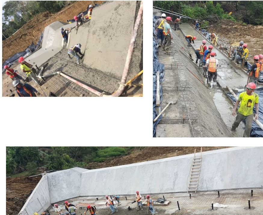
Figura 5: Proceso Constructivo Vertedor de excedencias Canal Japdeva-río Limoncito
